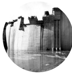
Construction du barrage de Vouglans, Photographie de 1968
