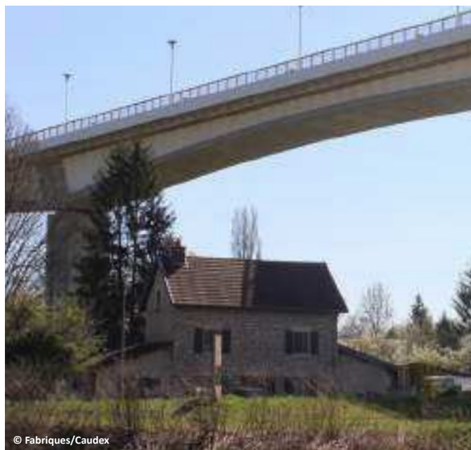
Le pont de la corniche vu depuis le chemin de halage.
