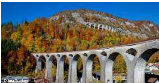
Viaducs ferroviaires entre Morbier et Morez.
